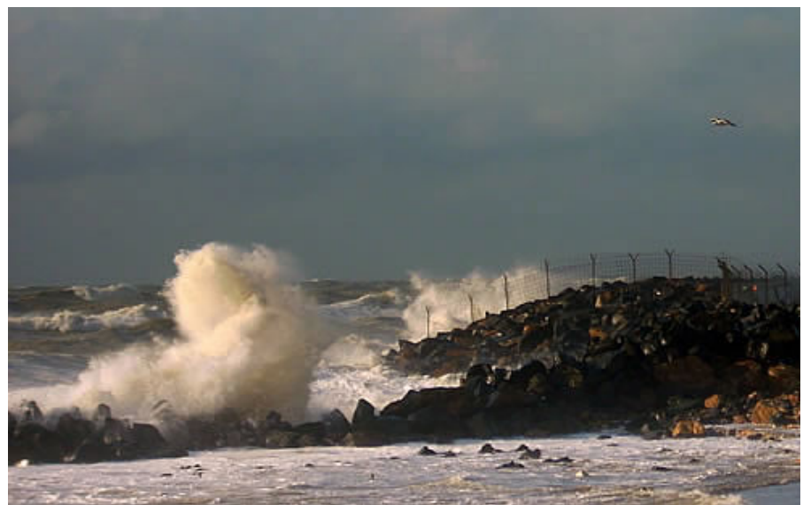
Taip atrodo Ostijos pakrantė pučiant stipresniam vėjui – įplaukti į uostą reikia su lūžtančiom bangom, todėl uosto vartai sudvigubinti, padarytas avanportas, turintis slopinti bangavimą uoste. Akmenys – tai bunos, supiltos išilgai visos pakrantės.
